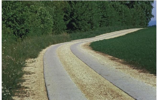
Bild 3: Beton-Spurweg
