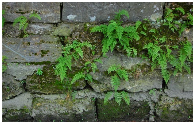
Abb. 2: Lebensraum Mauer. Manche alte Mauern stellen wertvolle „Ersatzfelsen“ für gesteinsbewohnende Moose, Flechten und Farne dar. Auf derartige Sekundärbiotope sollte zum Erhalt der biologischen Vielfalt bei Ortslageverfahren geachtet werden. Foto: Dr. Andreas Zehm
