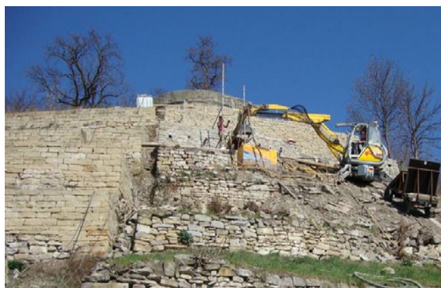
Abb. 43: Trockenmauersanierung am Asperg. Das Landschaftselement Trockenmauer spielt für zahlreiche europarechtlich geschützte Arten (z. B. Mauereidechse oder Schlingnatter) eine wichtige Rolle als Lebensraum. Werden sie im Rahmen von Flurneuerungsverfahren saniert oder neu aufgebaut sind zwingend artenschutzrechtliche Aspekte zu berücksichtigen. (Foto: Christine Hipp)
